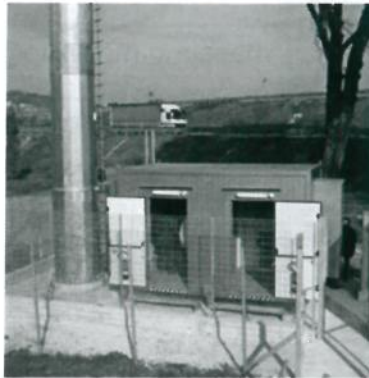
Figura 4-1: es. Sito autostradale
